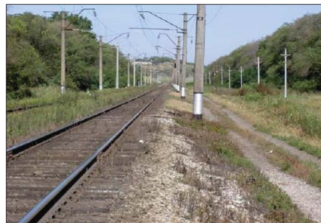
Грейдер в норме расхода 5 л/га хорошо очистил полотно от сорняков
