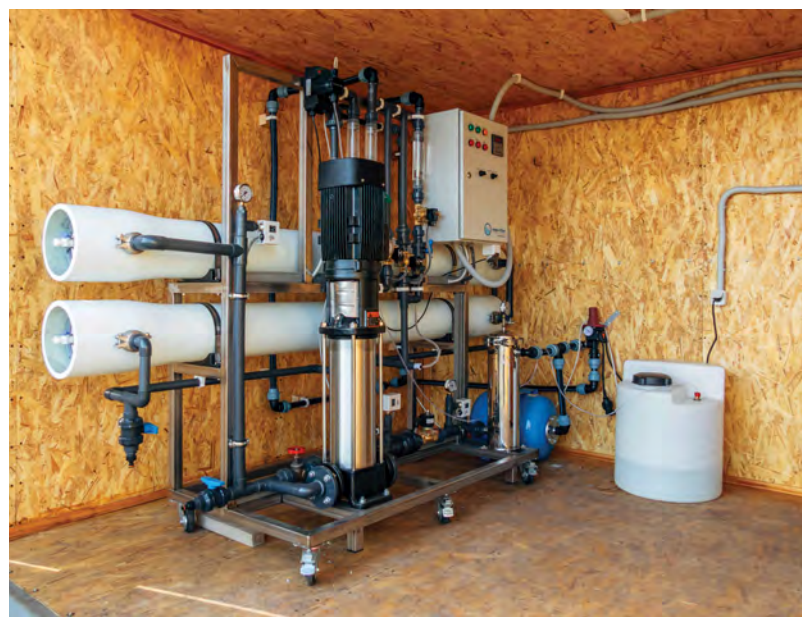
Установка обратного осмоса воды
