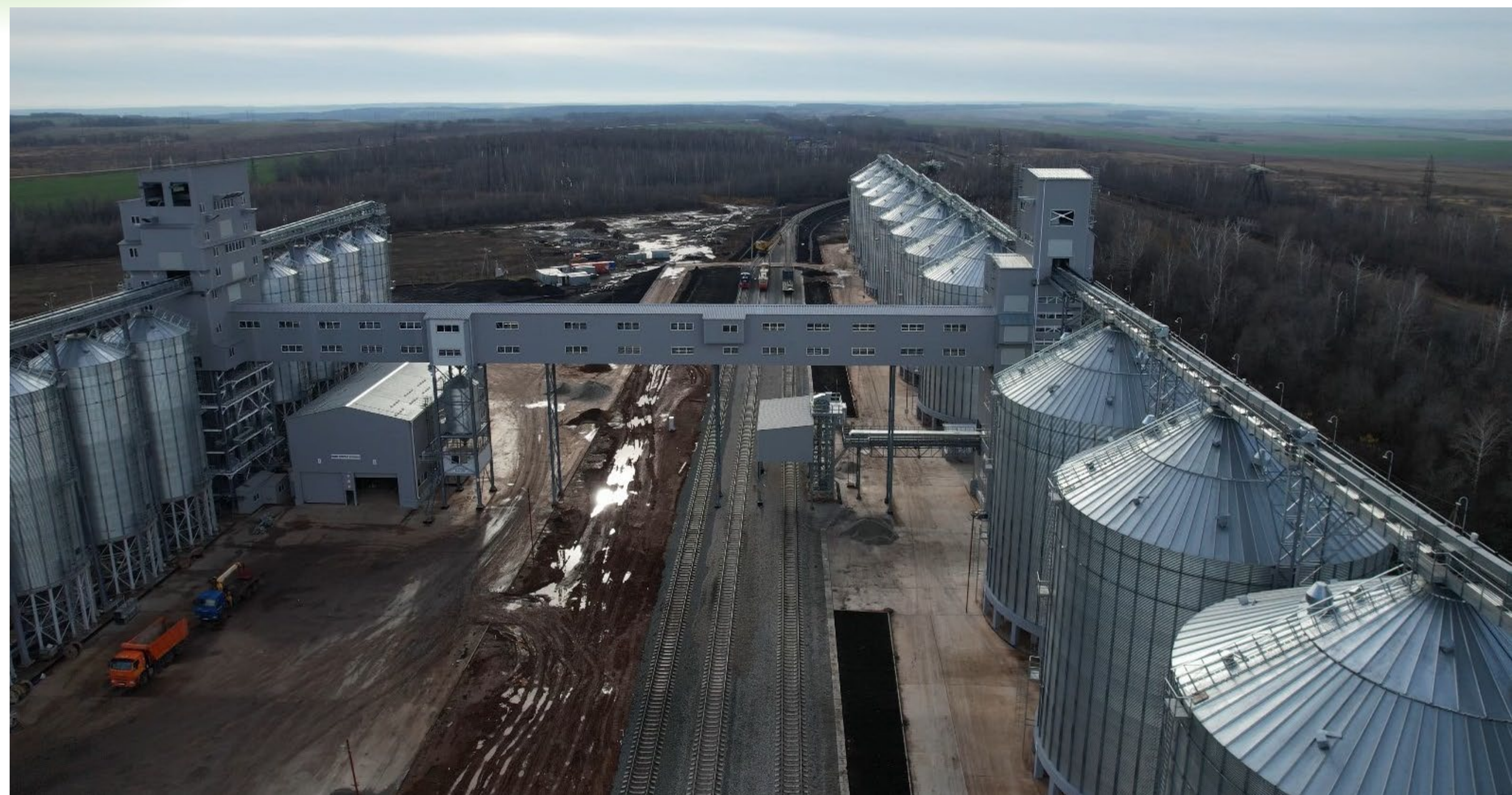
Процесс строительства элеватора в Бугульме
