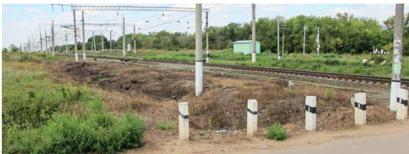
Фото 14. Результат обработки полосы отвода вблизи железнодорожного переезда на участке пути Липовский - Зоринский, Саратовская дистанция пути – ПЧ-11 баковой смесью Магнум®, 0,2 кг/га + Торнадо® 500, 3,5 л/га + Адыо®, 0,2 л/га. Обработку проводила подрядная организация ОАО «РЖД» – ООО «Арсенал», 2012 г. По информации заместителя начальника дистанции искусственных сооружений А. А. Клочкова, растительность на этом участке в 2018 году отсутствовала.
