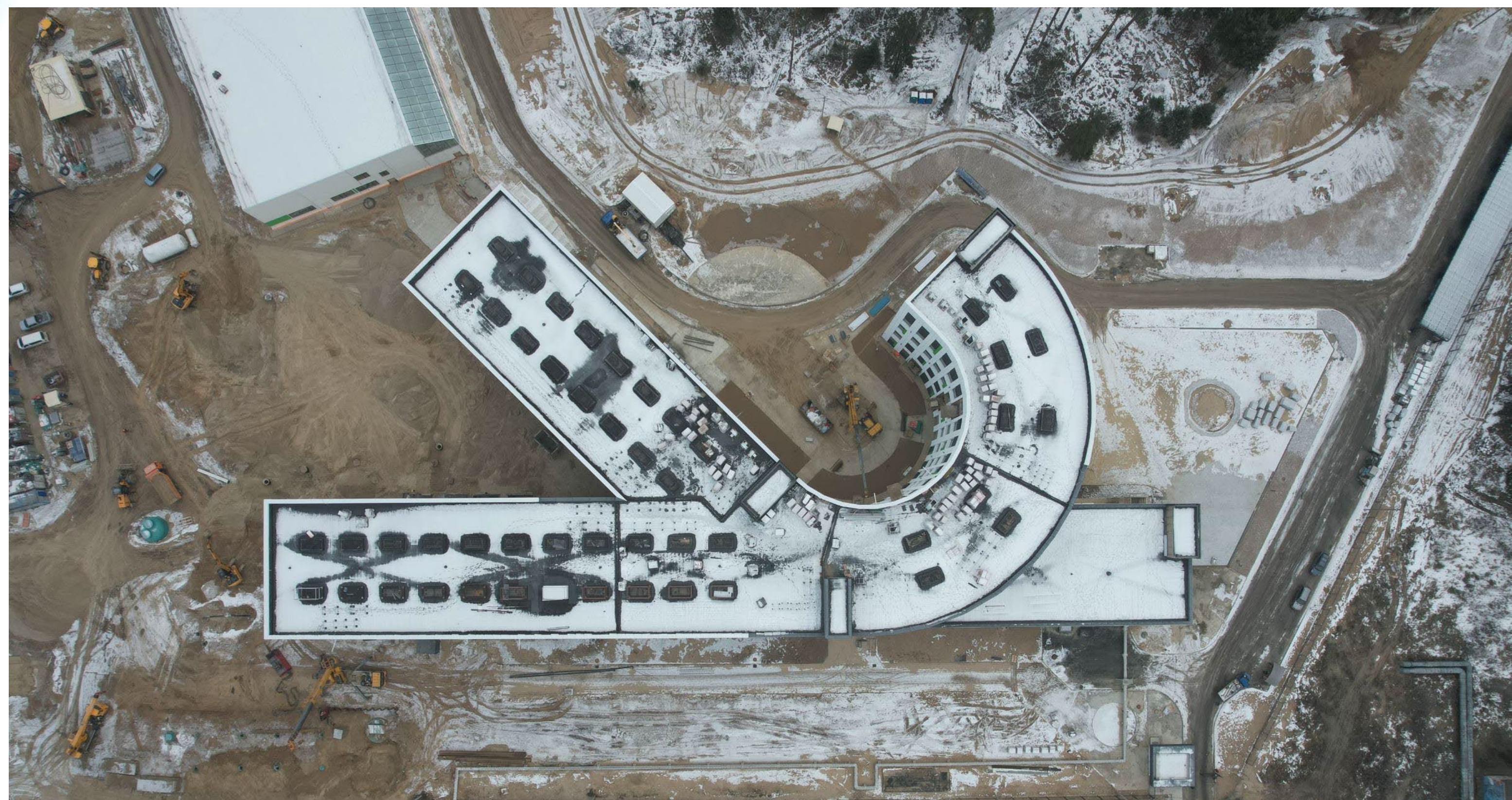
Процесс строительства. Декабрь 2024 г.
