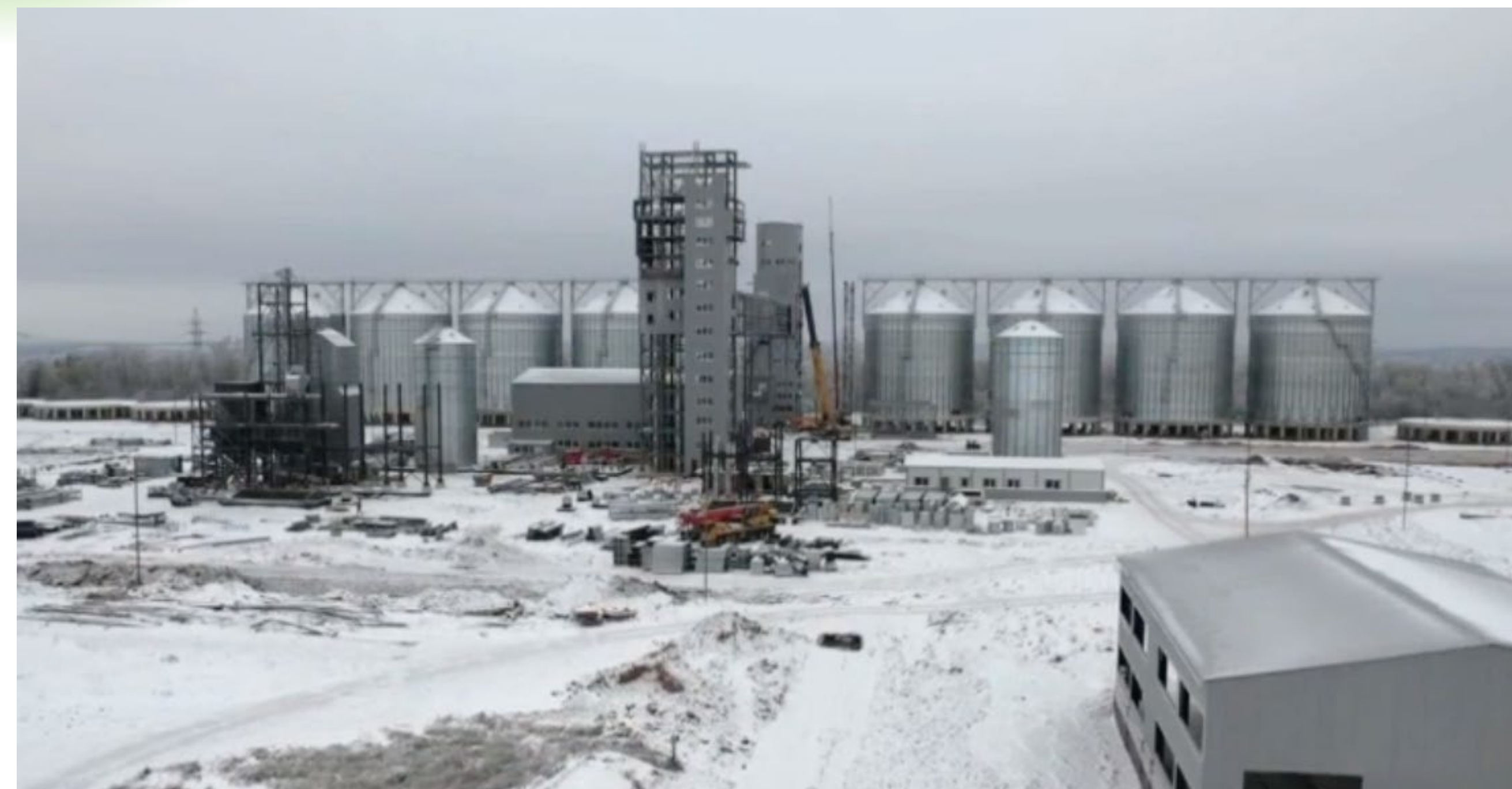
Процесс строительства элеватора в Бугульме
